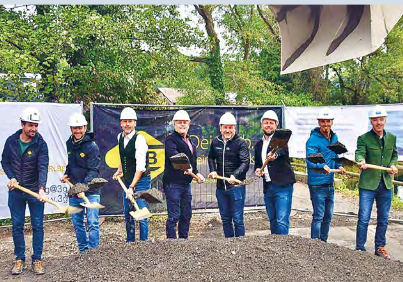
Spatenstich für die Baustappe 3 auf Quadern
