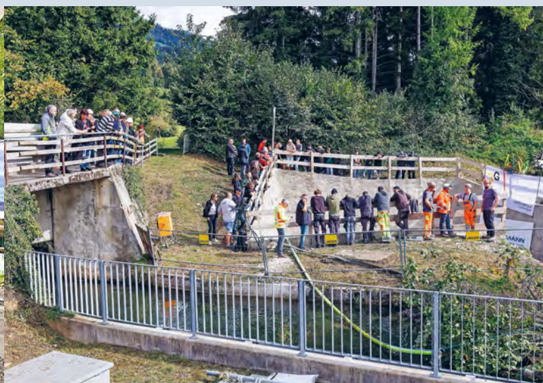
Reges Interesse beim Durchstich in den Zielschacht von „Fuxxi-Tommy-Buddli“
