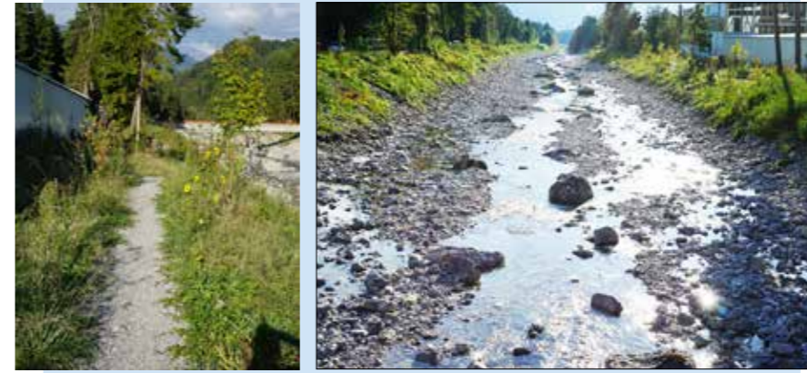
Nach dem erfolgreichen Abschluss des 1. Bauabschnittes folgt nun die letzte Etappe der Revitalisierung.
